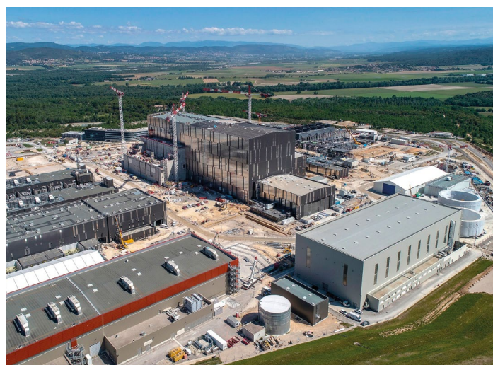
Obr. 2 Vizualizace a staveniště plánovaného tokamaku ITER (S laskavým svolením ITER). Dostupné z: https://www.iter.org/doc/all/content/com/gallery/media/7%20-%20technical/tkm_cplx_final_plasma2013-07.jpg
